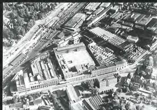
INDUSTRIESIEDLUNG EINST UND MORGEN Das Sulzer-Areal in Winterthur, 1959 (oben), Visualisierung des Innovationsparks Sântisblick auf dem Flugplatzgelände in Dübendorf ZH.
