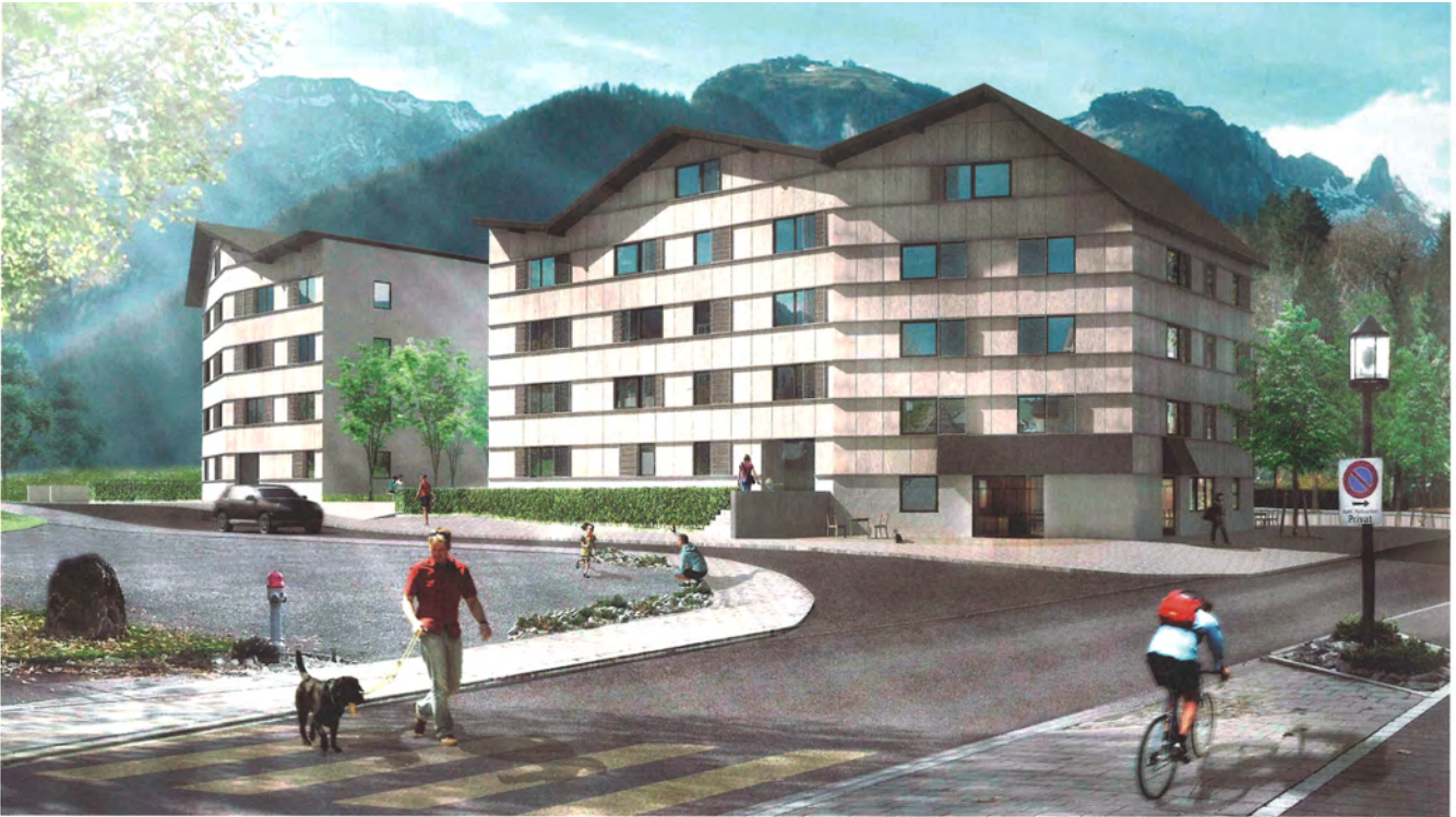
Blick von der Dorfstrasse auf die zwei Neubauten
