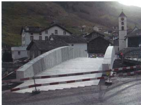
写真6—最新作Valserrheinbrücke Vals Platz. 建築設計ピーター・ズントー、構造設計ユルグ・コンツェット
