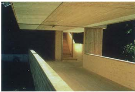
写真4—Mursteg Murau/Steiermark (A), 1993-1995
