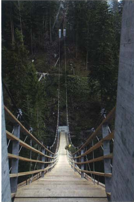
写真5—Zweiter Traversiner Steg, Viamala, 2005
